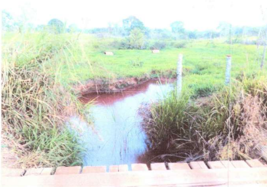
Figura 2: P2 - BUEIRO LINHA LC-25 COORDENADAS (20L 467155.82 8867208.46)
