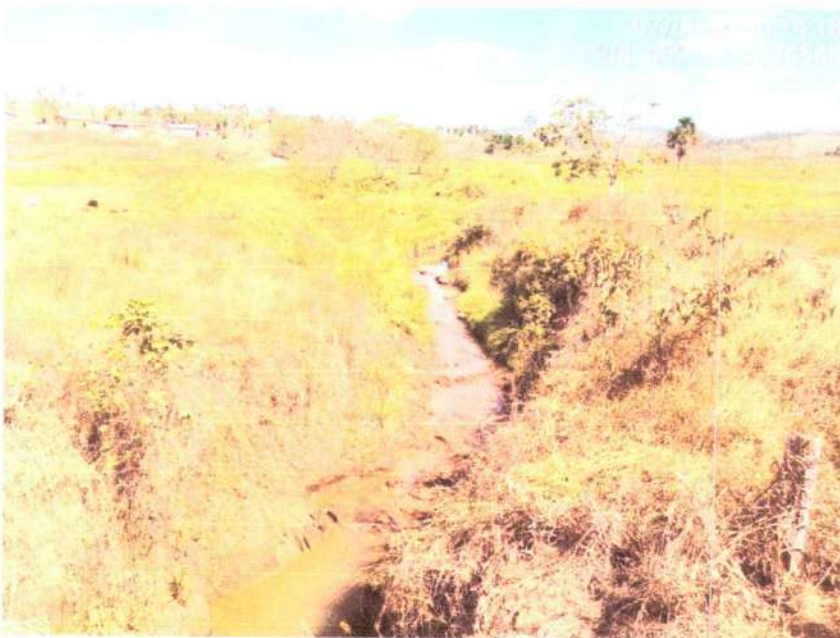
FIGURA 4: P4 - BUEIRO LINHA LC-52 COORDENADAS (20L 459731.63 8894542.97)
