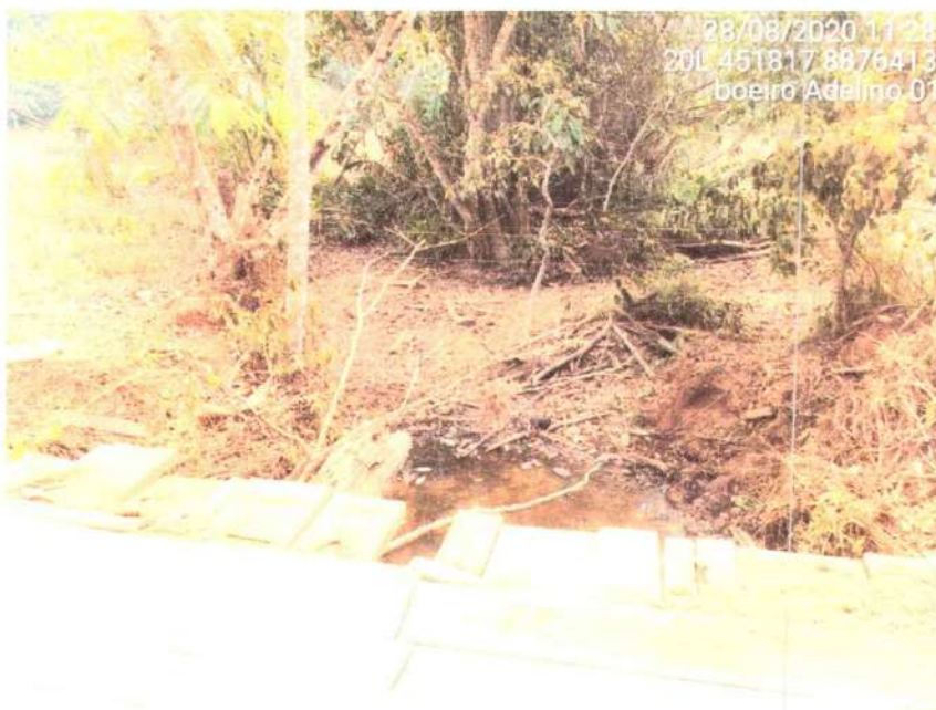
FIGURA 5: P5 - BUEIRO LINHA LC-35 COORDENADAS (20L 451817.00 8876413.00)
